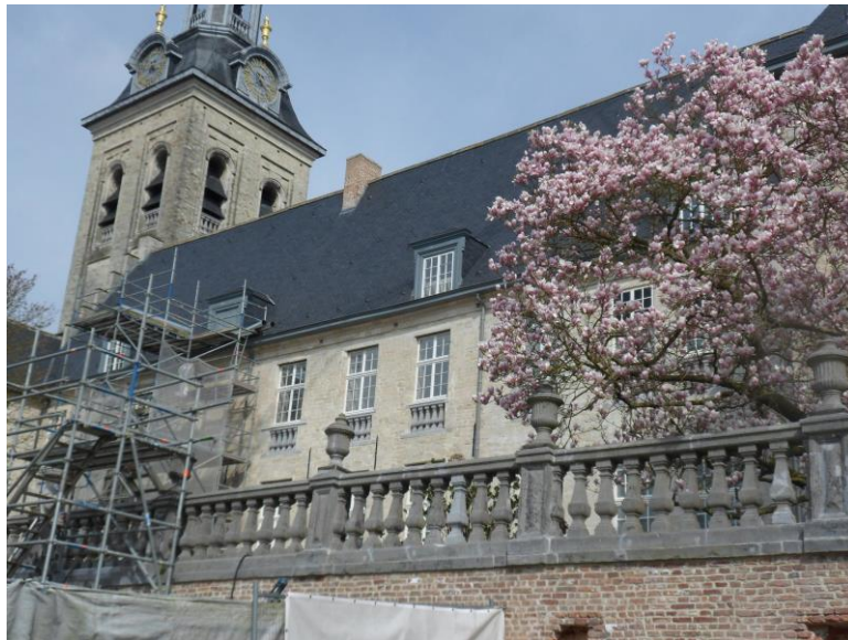
De westvleugel in restauratie , begin van de lente 2015
